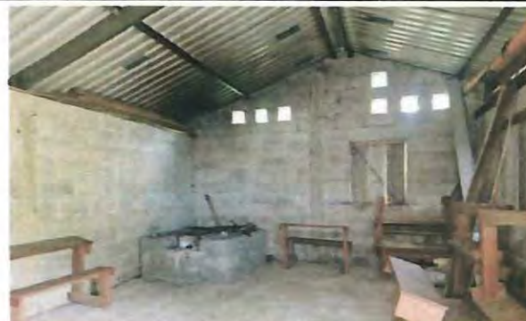
Foto 4: Mejoramiento de estufa rural e instalacion de tubos de concreto y ceramica antideslizante en cocina.
