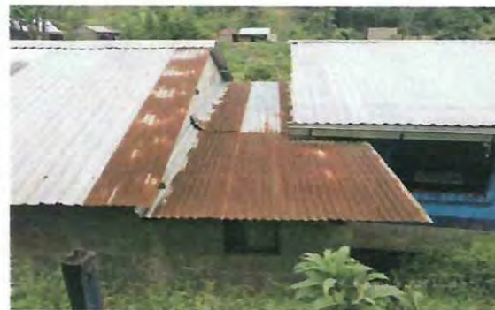
Foto 2: Cambio de costaneras de madera por costaneras metalicas y cambio de laminas comunes por laminas troqueladas
