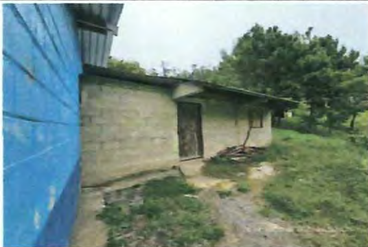
Foto 1: Instalacion de ventanas-balcon, y puertas de metal, así mismo torta de concreto y cernido con monocapa parte frontal lateral y trasera de la cocina.
