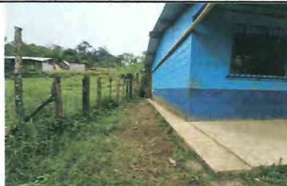
Foto 8: Sustitucion de valla de alambre de puas por malla galvanizada en el perimetro de la escuela.
