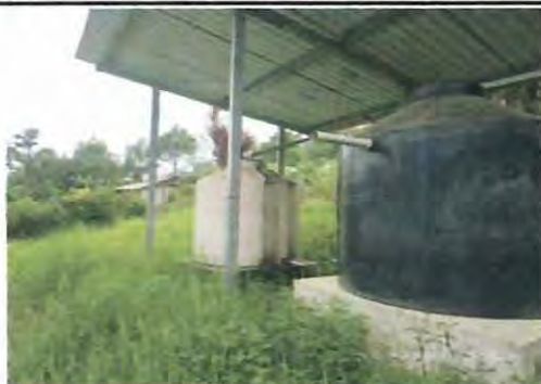
Foto 7: Colocacion de tinaco de 2,500 litros a un costado de los que estan actualmente, asi mismo la coloccion de sus accesorios, y base de acentamiento.
